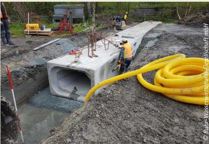
Einbau des Rahmenprofils 1 250/750 mm mit Auslass zur Lenne
